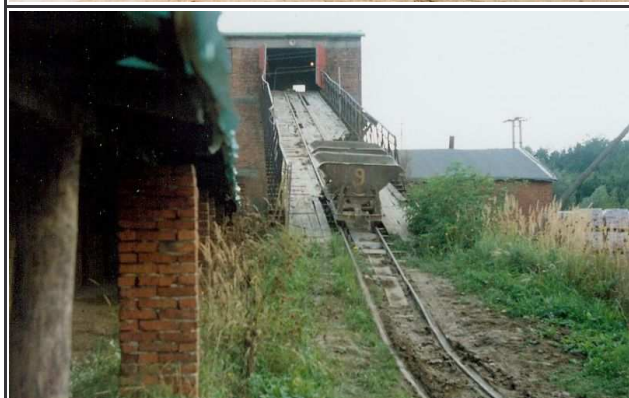
Puste koleby opuszczają szyb rozładunkowy
