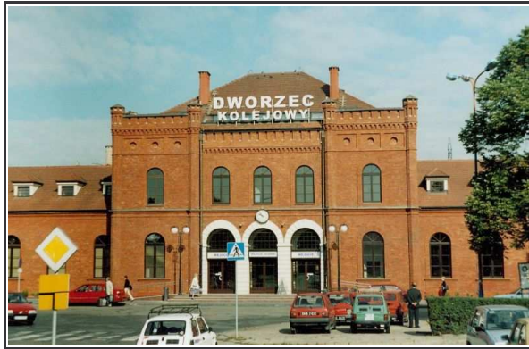
Dworzec po zakończeniu remontu w roku 2003
